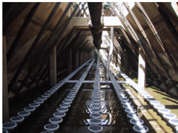
Neue Belüftung vor der Inbetriebnahme im Juli
