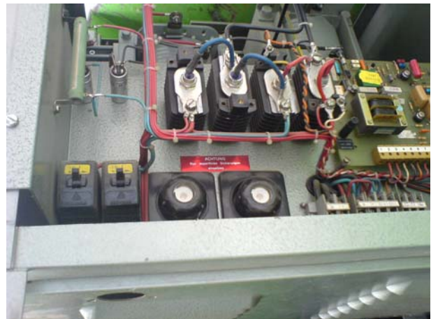
Batterien und Ladegerät für 24 und 48 V Ventilsteuerung und Notlicht
