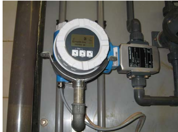
neue Durchflussmessung
