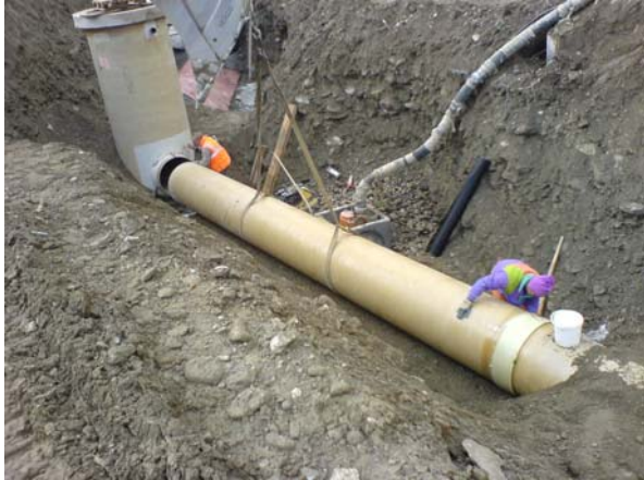
Das letzte Rohr wird eingebaut Die 1. Etappe ist mit der 2. verbunden
